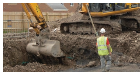
Funderingsmateriaal wordt op het TriAx geogrid aangebracht vóór volledige verdichting.
