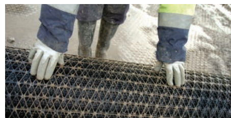
TriAx geogrid wordt op locatie uitgerold.
